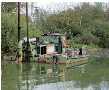
A természetes szakaszokon a partok érintetlenül hagyásával, úszókotróval történik az üledék eltávolítása, a partról történő mederfenntartás féloldali kotrással történik
