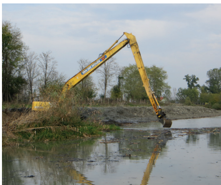
A természetes szakaszokon a partok érintetlenül hagyásával, úszókotróval történik az üledék eltávolítása, a partról történő mederfenntartás féloldali kotrással történik
