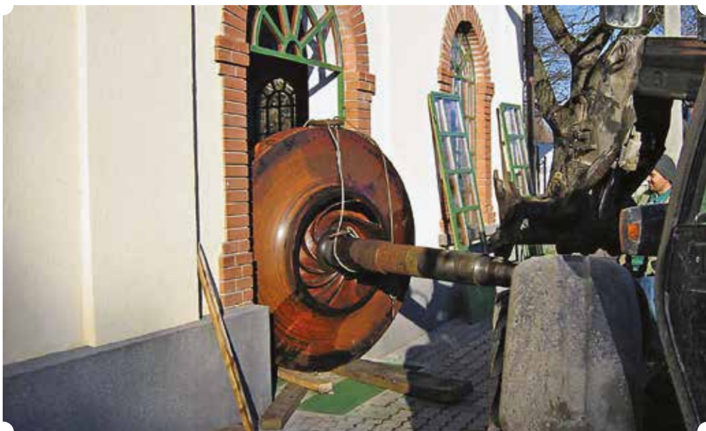
Lapátcsere a szivattyútelepen 2008-ban
