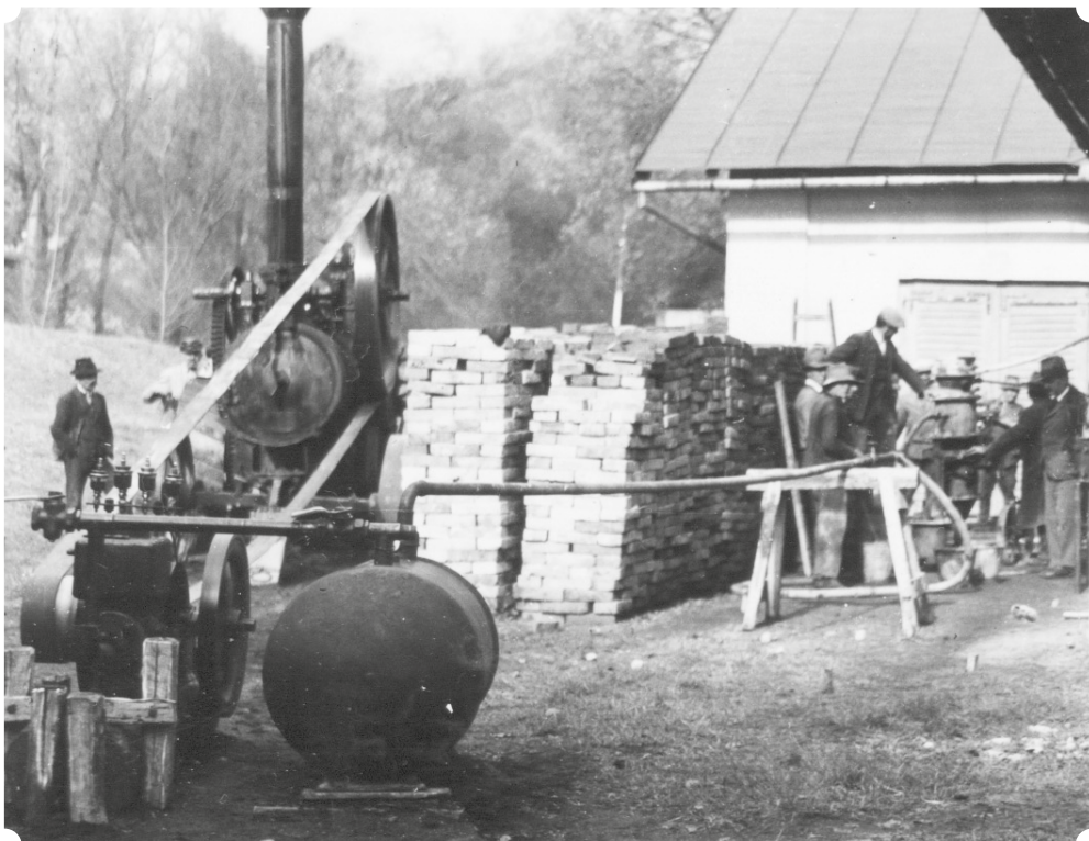
A szivattyútelep alápréslési munkája 1937. évben (Sági Jenő gyűjteménye)
