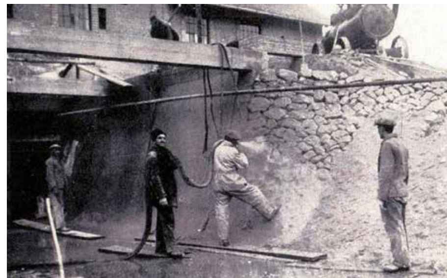
Az előágazat kikövezett oldalfalának befuvatása betonnal
