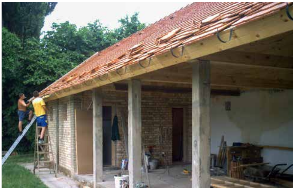
Melléképület tetőzetének felújítása
