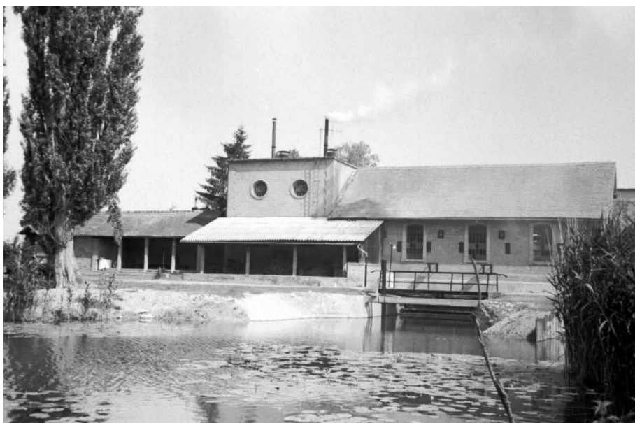
A Karapancsai szivattyútelep befolyó – szivó – oldala, Sági Jenő gyűjteményéből (1985)
