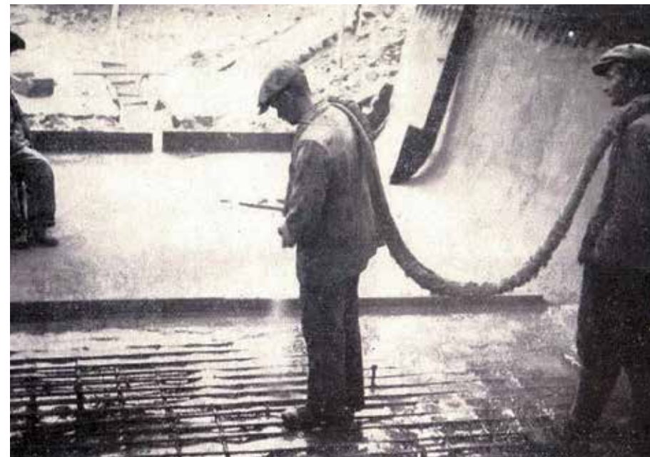
A fenéklemez készítése betonfuvatással
