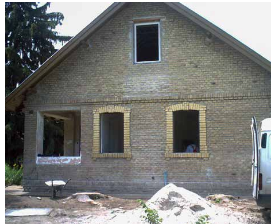
Kiállítóhely homlokzata a felújítás alatt
