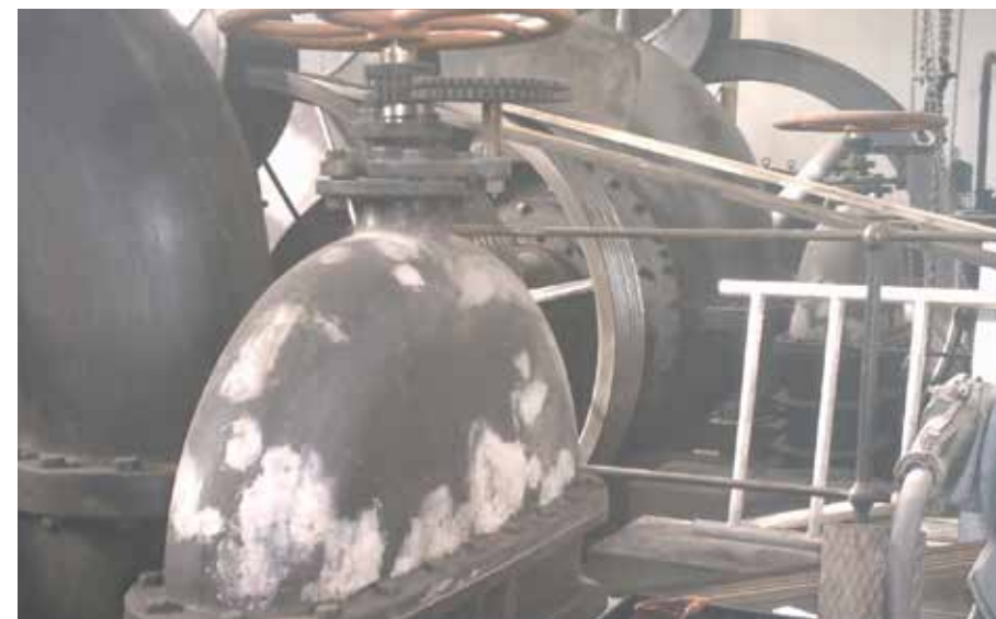
Restaurálási munkálat közben
