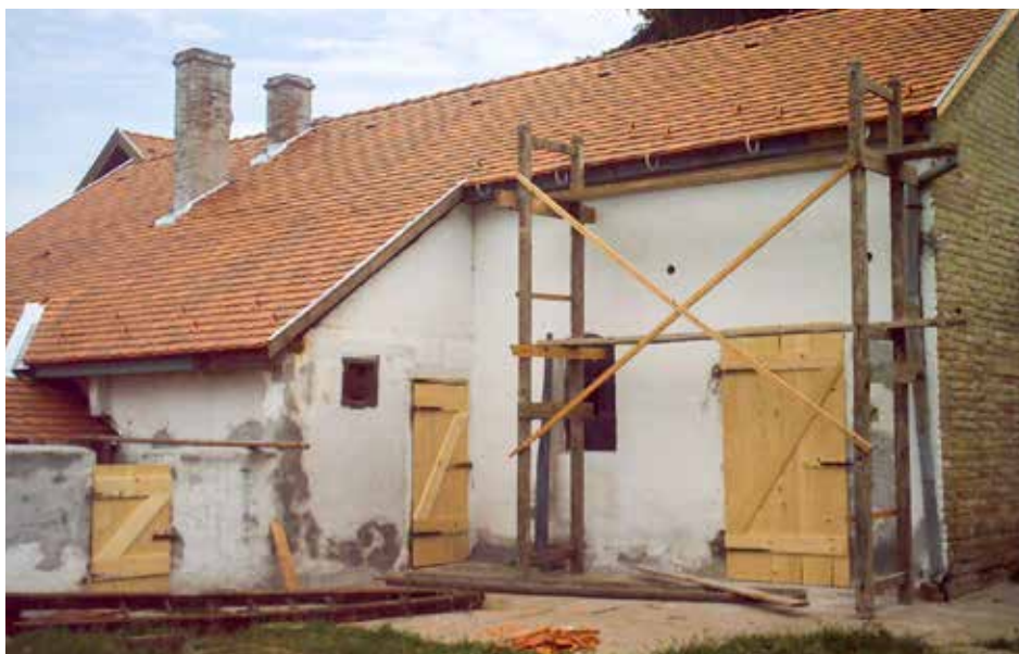
Állattartó épület állagmegóvó felújítása
