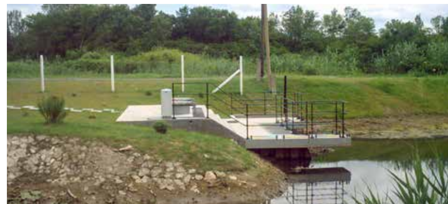
Új szivattyúk kiépítése
