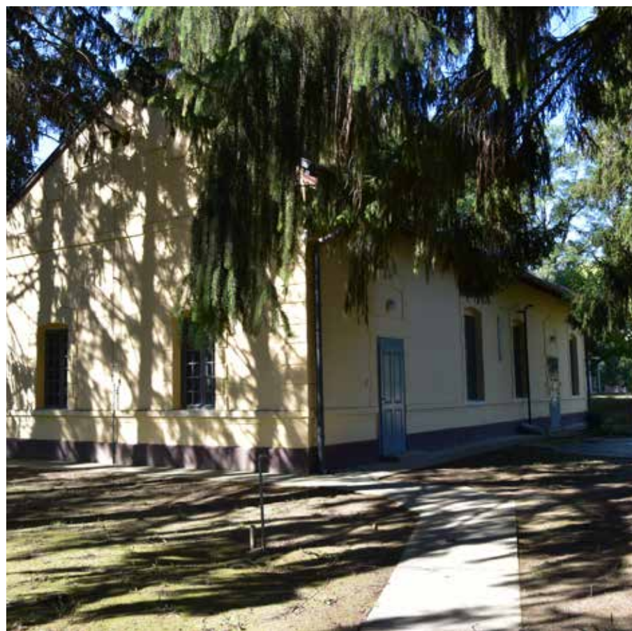
A Hercegszántói szivattyútelep napjainkban
