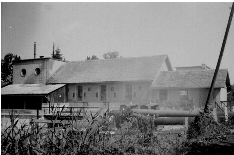
A Karapancsai szivattyútelep befolyó – szivó – oldala, kisegítő szivattyú provizóriummal, Sági Jenő gyűjteményéből (1985)
