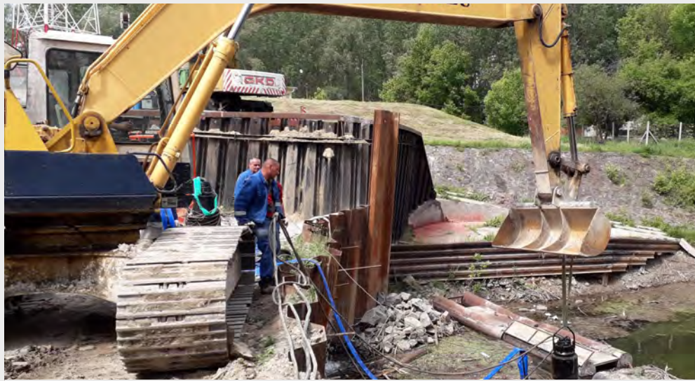
Búvárszivattyúk telepítése a vízpótló rendszerhez a munkatér felvizi oldalán
