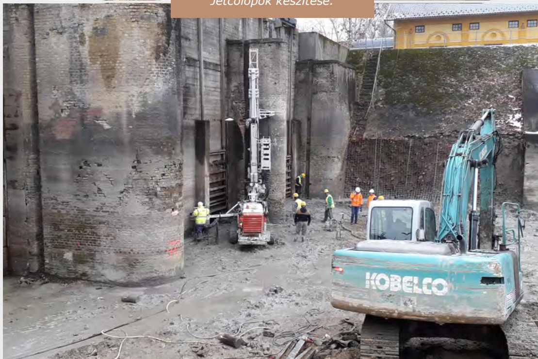
Jetcölöpök készítése.
