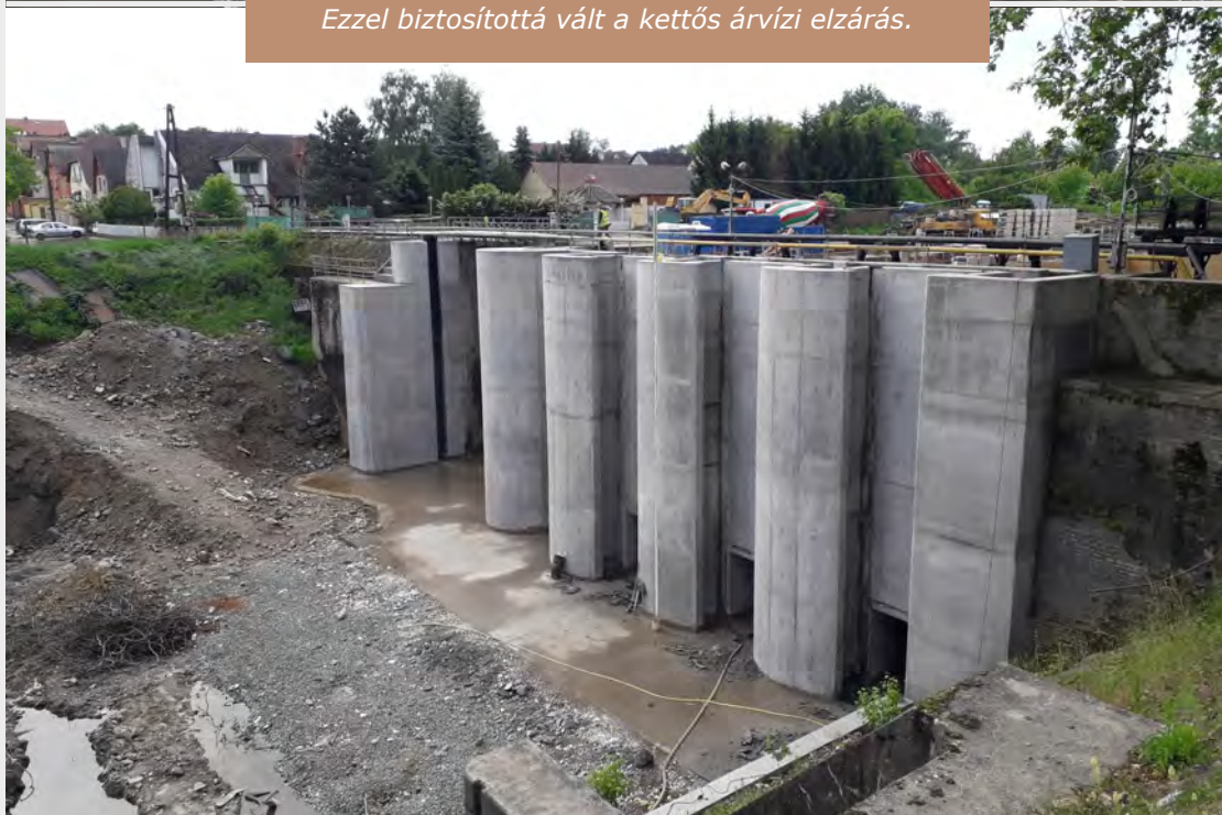
Az elkészült vasbeton orrfal a zsilip felvízi oldalán. Ezzel biztosítottá vált a kettős árvízi elzárás.
