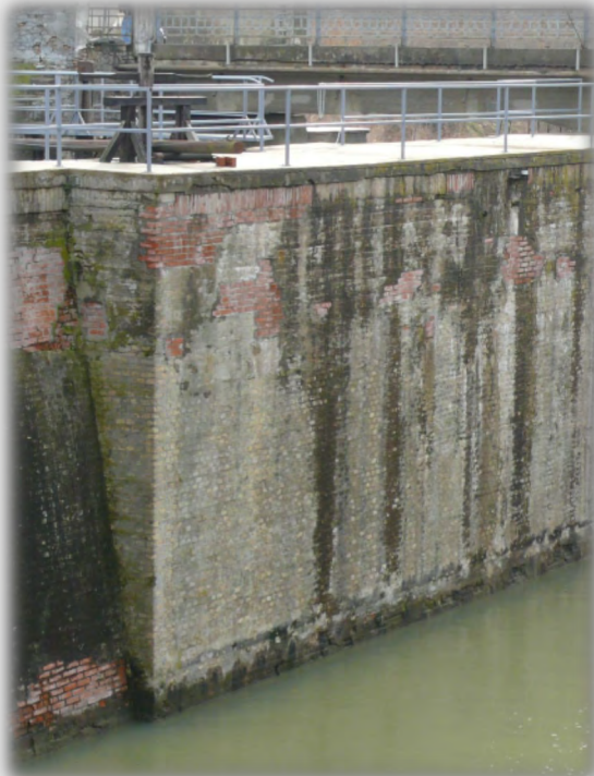
A táp- és hajózsilipek téglafalazatának állapota a rekonstrukció megkezdése előtt
