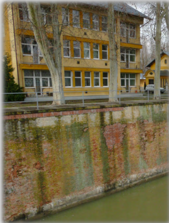
A táp- és hajózsilipek téglafalazatának állapota a rekonstrukció megkezdése előtt
