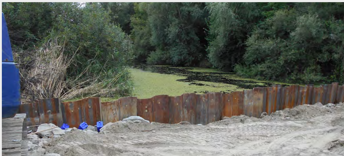
Szádlemezes jászolgát építése a Deák Ferenc-zsilip alvízi oldalán
