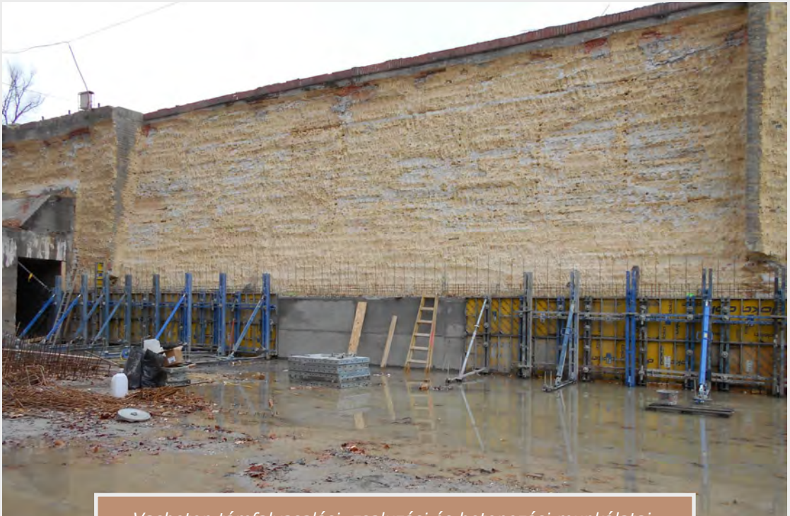
Vasbeton támfalvasalási, zsaluzási és betonozási munkálatai.
