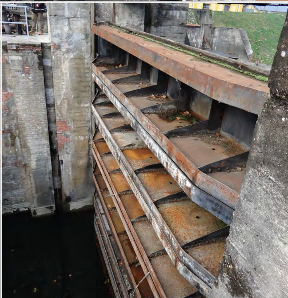
A hajószilip árvízi elzárására használt betétgerendák amunkaterület átadásakor
