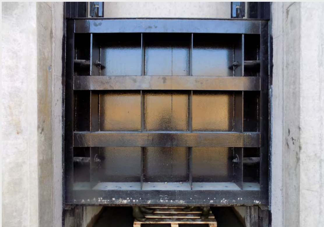
A tápszilip új elzárószerkezeteinek szerelése és beépítése
