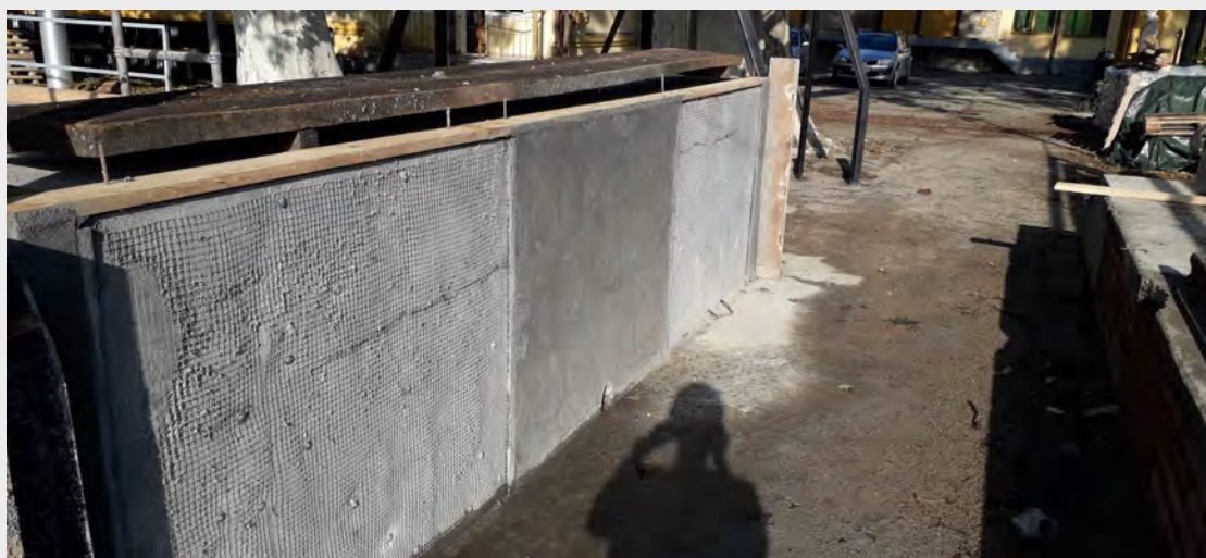
Betonfelületek vakolási munkálatai
