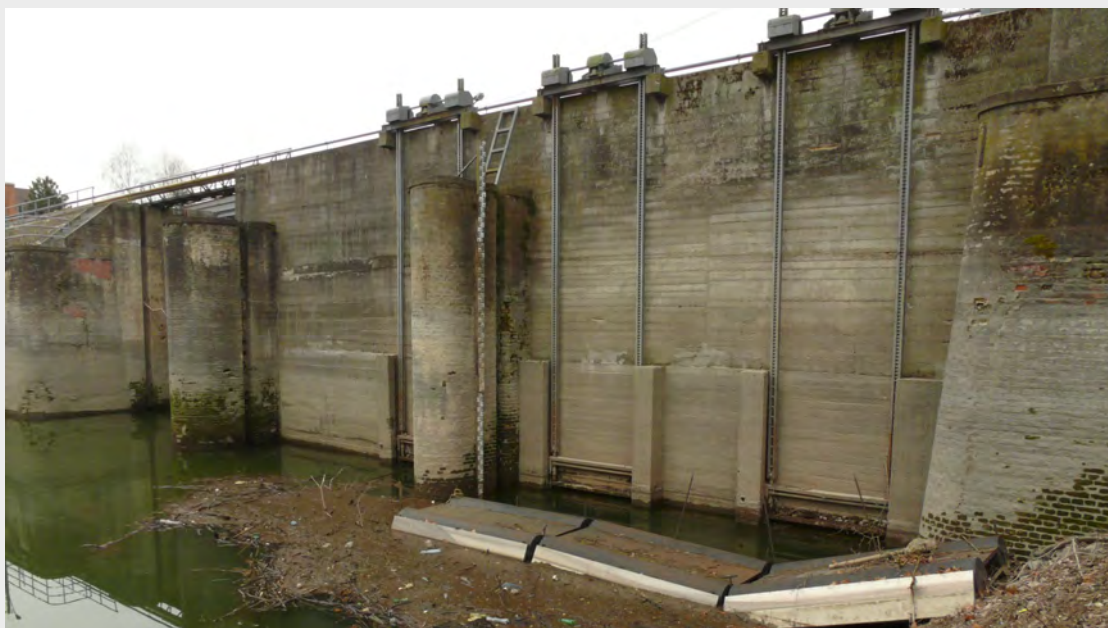
A Deák Ferenc-zsilip a rekonstrukció megkezdése előtt a felvízi oldal felől
