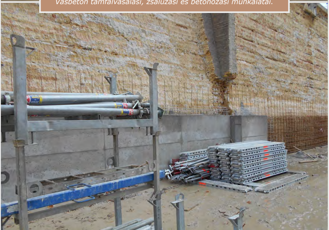
Vasbeton támfalvasalási, zsaluzási és betonozási munkálatai.
